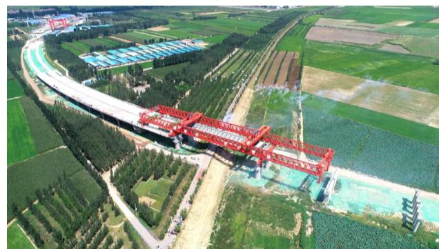
本报讯 近日，六公司参建的孟州黄河大桥首片80米钢箱梁架设成功，这次架设是我国建桥史上首次采用特大型架桥机双幅整孔架设80米钢箱梁。
