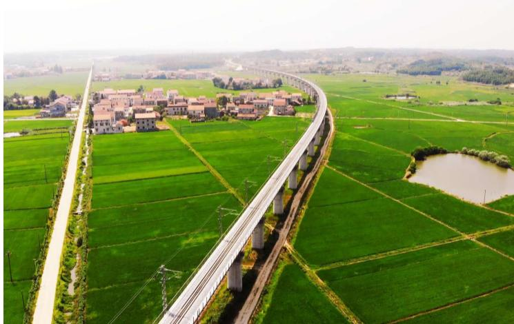
近日，一公局集团浩吉铁路（原蒙华铁路）MHTJ-27标通过动态验收。浩吉铁路是目前世界上一次建成里程最长的重载铁路和国内规模最大的运煤专线，线路全长1814.5公里。27标全长约68公里，施工过程中，穿越三条断裂带，结构受力复杂、施工难度大、安全风险高。
