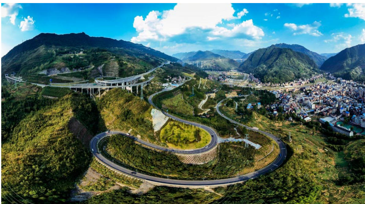
近日，三公司承建的国道318线、348线重庆万州段路面改造工程顺利完工。该项目路段位于重庆万州区境内，路线全长98公里，途经12个乡镇，主要施工内容包括维持原公路等级标准和路基路面宽度，采用橡胶改性沥青混凝土对原路面进行升级。项目建成后，将进一步构建重庆万州“一环八射”高速公路网，方便当地居民出行，助推渝东北形成市域干线公路网络。
