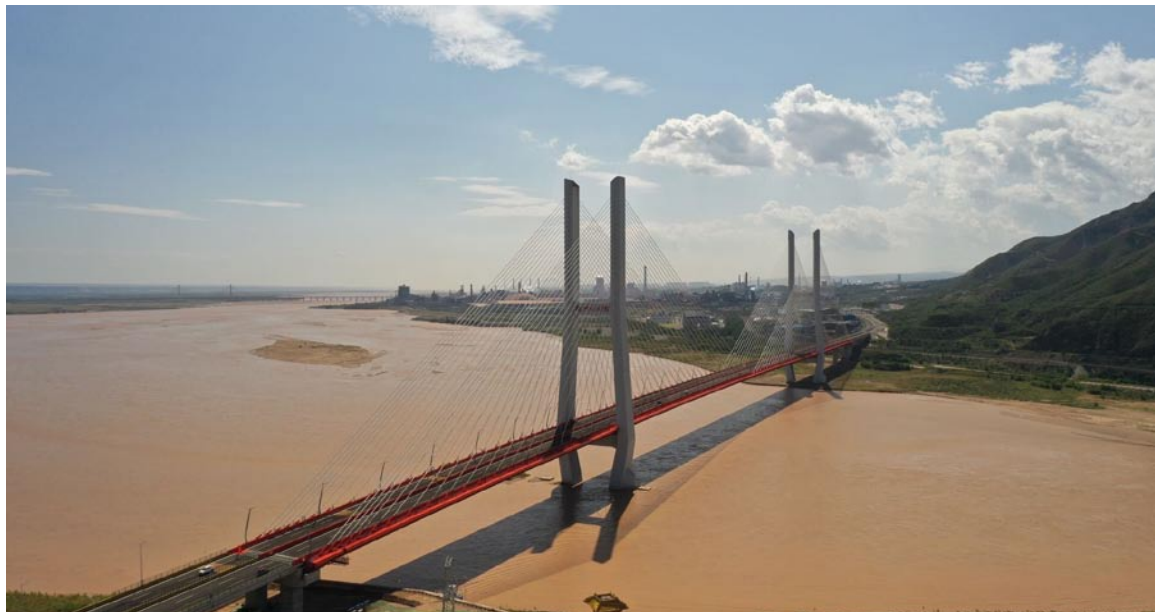
近日，由西北公司承建的国道108线禹门口黄河大桥正式通车运营，为连接秦晋两省再添新坦途。禹门口黄河大桥位于陕西省与山西省交界处，连接韩城市与河津市。大桥为三跨双塔双索面斜拉桥，路线全长4.45公里，采用双向六车道标准建设，设计时速80公里，其中主桥长1.6公里，主跨565米，是西北地区跨径最大的斜拉桥。
