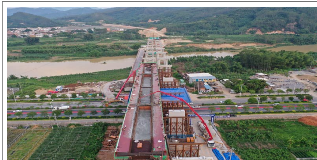
厦门公司漳武南靖A1项目现浇箱梁底板浇筑，采用钢管普通贝雷+盘扣支架，施工过程严格按照设计及规范要求，确保工程质量。
